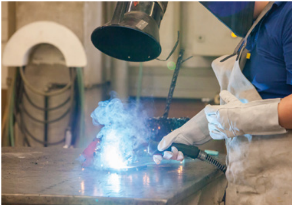
Gase und Dämpfe , die beim Schweißen entstehen, belasten die Luft stark und müssen abgesaugt werden.
