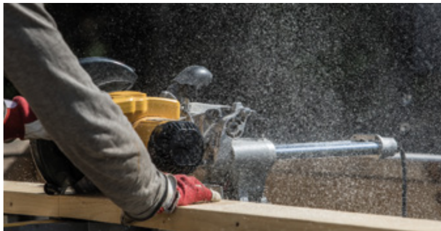
Hartholzstäube können Krebserkrankungen verursachen.
