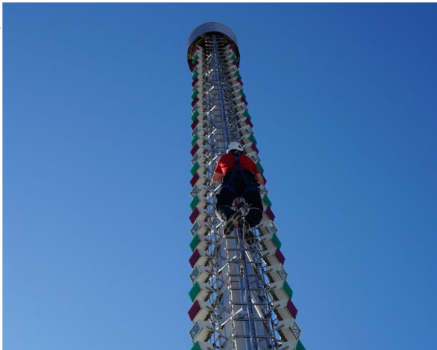
Lampentausch am Wettermast – die Sicherheit der ArbeiterInnen steht dabei im Vordergrund.
