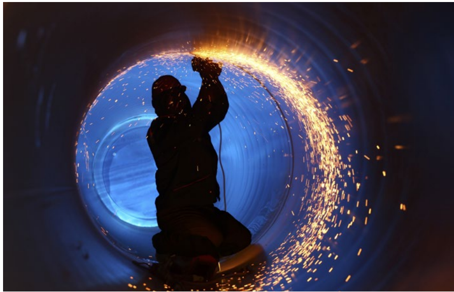
Bei Schweißarbeiten kann auch Ozon entstehen. Schweißgase müssen daher abgesaugt werden.
