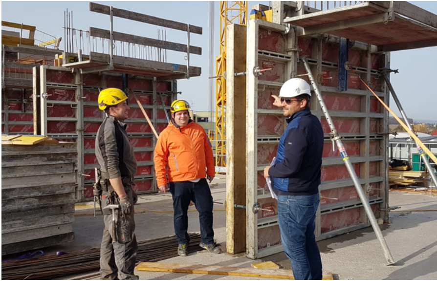
Unterweisung auf der Baustelle: v. l. Facharbeiter Andreas Lechner, SFK Ing. Martin Jell, SVP Ing. Günther Sax.
