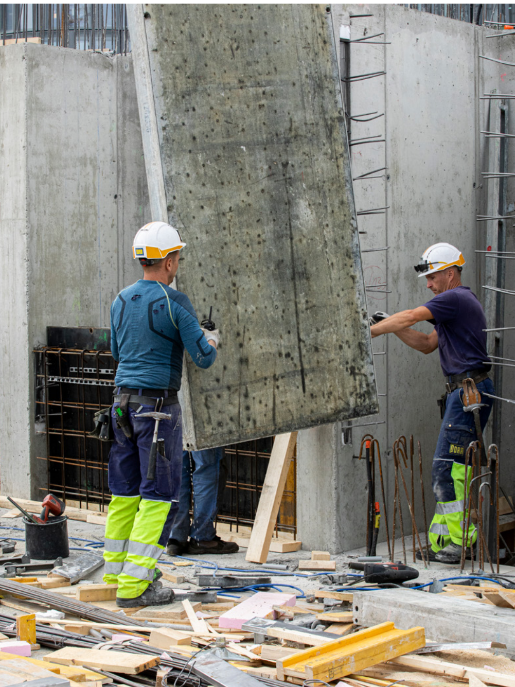
Kräne unterstützen die ArbeiterInnen beim Heben tonnenschwerer Bauteile.
